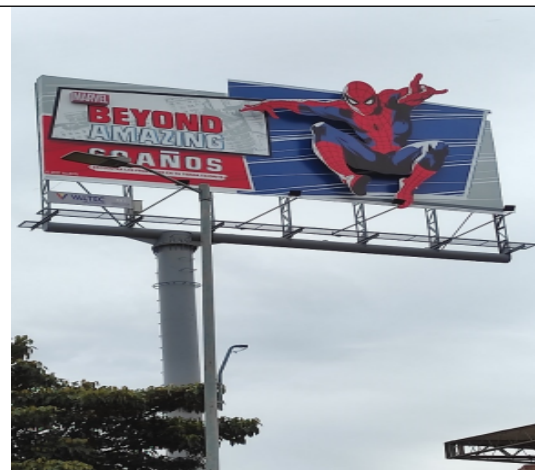
Foto 4. Vista en detalle del panel publicitario instalado.
